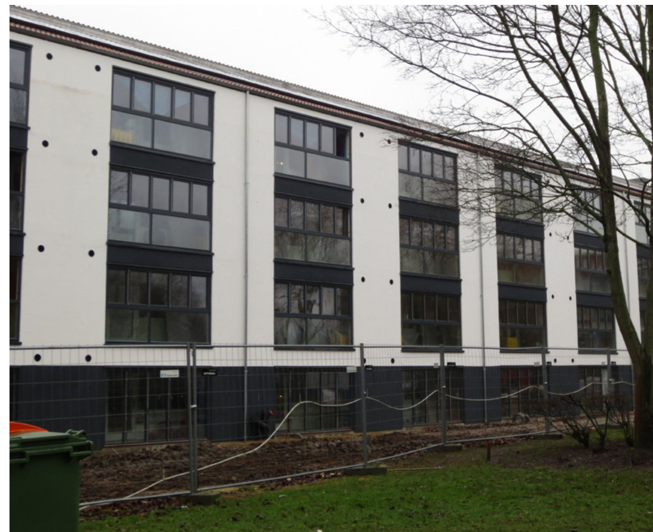
Første etape af en samlet renovering af hele Gadehavegård til super-lavenergi er gennemført i 2014. Projektet løftes med støtte fra EU og Energistyrelsen. Gadehavegård-bebyggelsen består af 19 blokke med ca. 2.500 indbyggere i næsten 1.000 lejligheder. 40 % af kommunens indbyggere bor i etageboliger, hvoraf mange er opført i 1970'erne.
